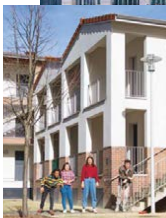
CAMPUS BORDEAUX-BASSIN À FLOT
