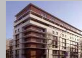
Hôtel Radisson Porte de Saint Cloud
