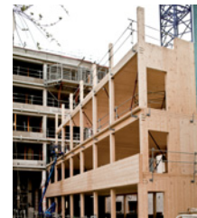
BUREAUX Construction du 1 er bâtiment à ossature bois à Neuilly-sur-Seine
