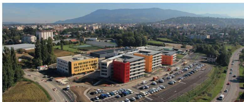
HÔPITAL PRIVÉ PAYS DE SAVOIE Annemasse - 74 Près de 24 000 m 2 - 250 lits Livraison à l'exploitant Générale de Santé
